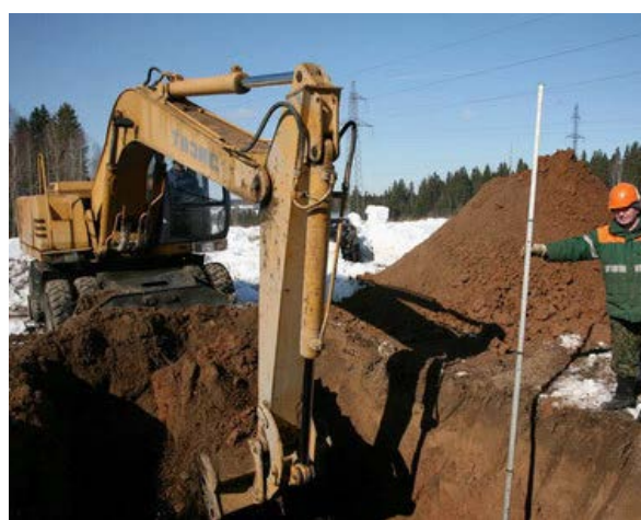
Рис. 46. Разработка грунта экскаватором, оборудованным обратной лопатой (торцевой забой)
