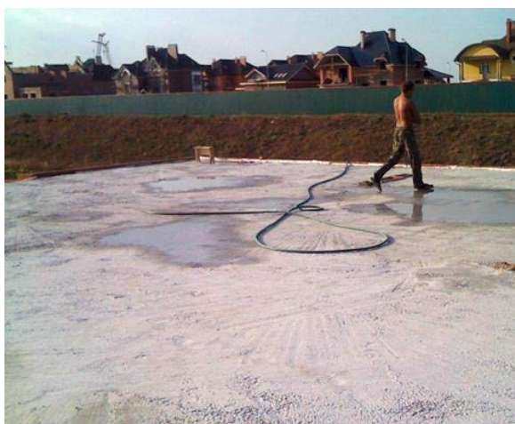
Рис. 64. Уход за бетоном розливом воды
