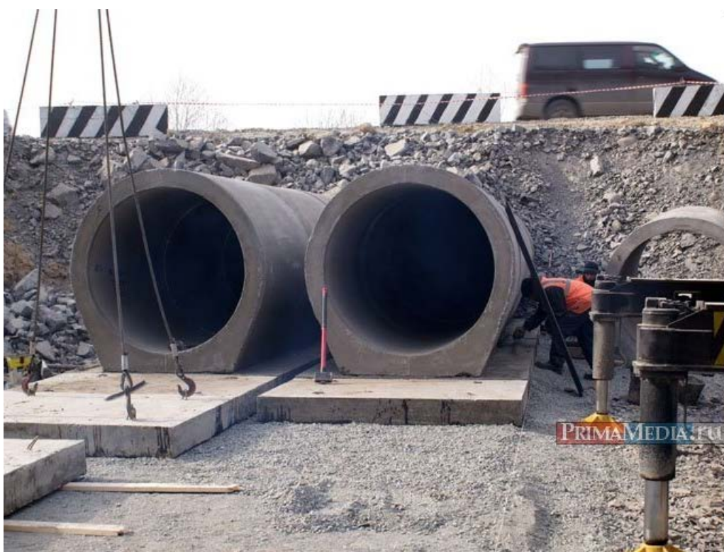
Рис. 9. Монтаж звеньев с плоским основанием на плоский фундамент
