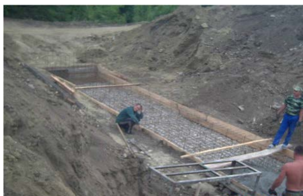
Рис. 58. Бетонирование фундамента трубы в направлении от выходного к входному оголовку
