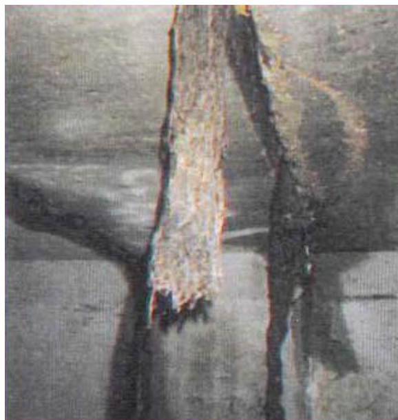
Рис. 87. Разрушение шва между звеньями прямоугольной трубы с ее внутренней стороны
