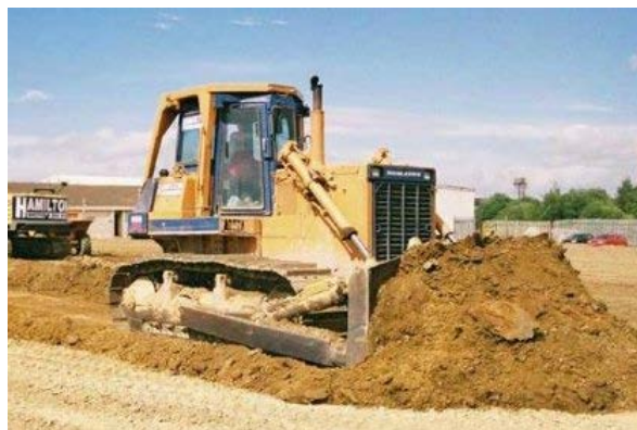
Рис. 44. Перемещение грунта бульдозером
