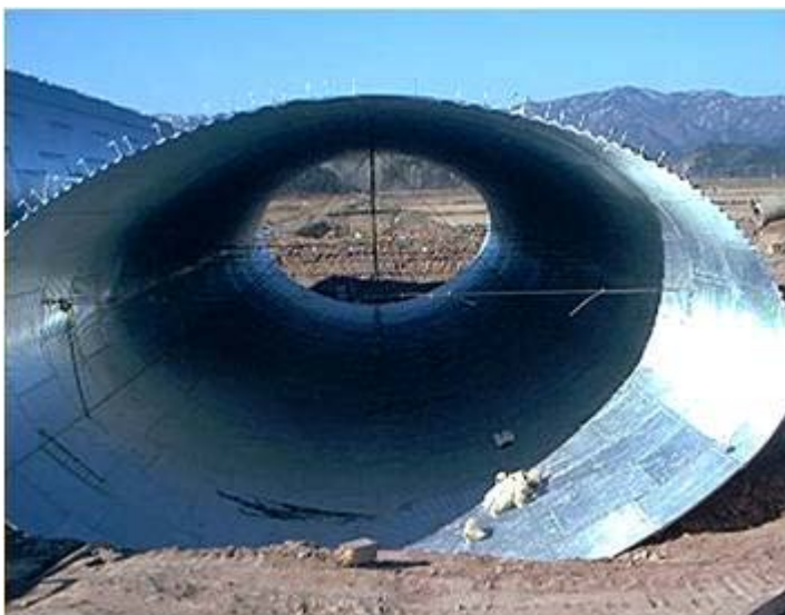
Рис. 14. Металлическая гофрированная труба с сечением в виде горизонтального эллипса
