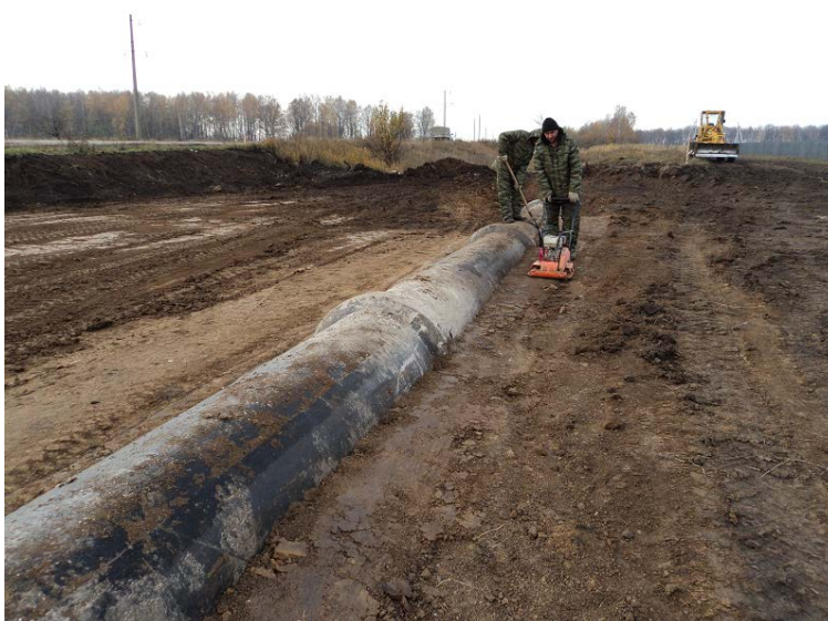
Рис. 109. Уплотнение грунта у поверхности трубы вибрационной плитой
