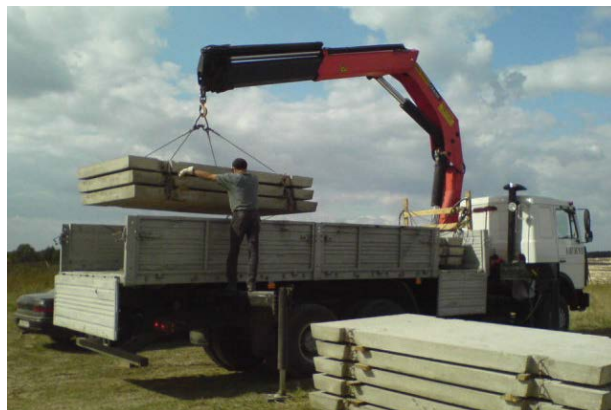
Рис. 37. Транспортирование плит краном-манипулятором
