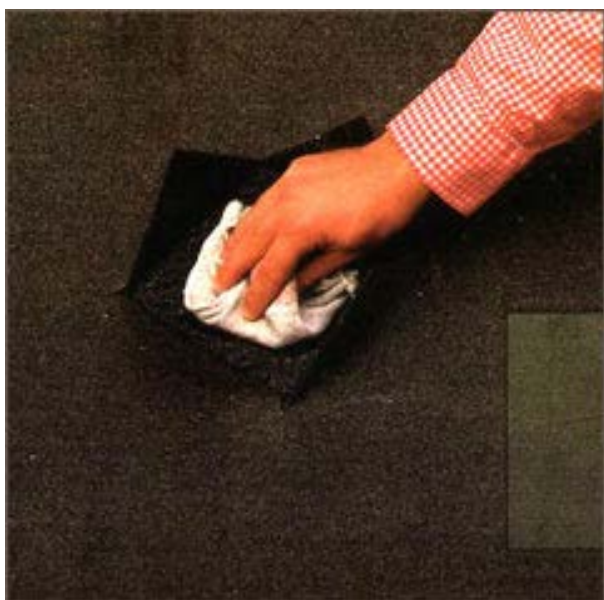
Рис. 99. Фрагмент протирания отогнутых концов ткани ветошью
