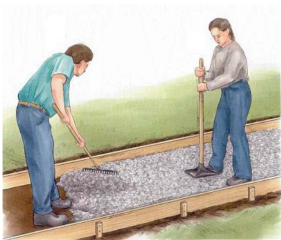
Рис. 53. Разравнивание и уплотнение материала подушки ручной трамбовкой
