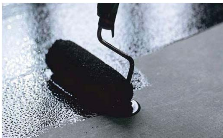
Рис. 98. Нанесение битумной мастики малярным валиком
