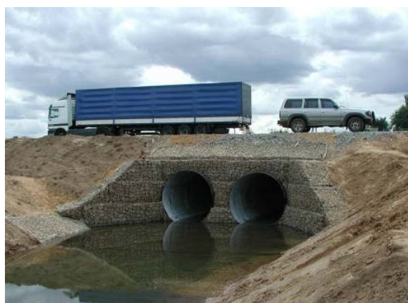
Рис. 13. Труба без скошенного торца концевого звена
