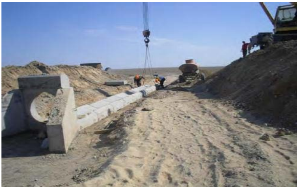
Рис. 66. Монтаж лекальных блоков, выполняемый после установки и крепления элементов выходного раструбного оголовка
