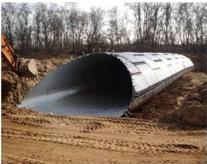
Рис. 15. Металлическая гофрированная труба с сечением в виде арочного замкнутого контура
