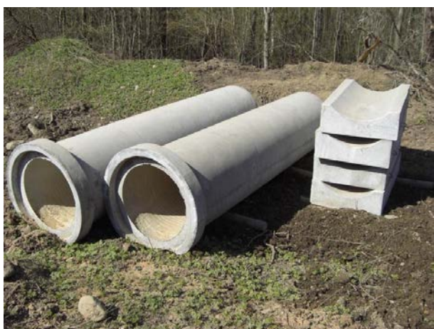
Рис. 38. Хранение элементов на строительной площадке
