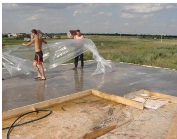
Рис. 65. Уход за бетоном розливом воды и укрытием полиэтиленовой пленкой
