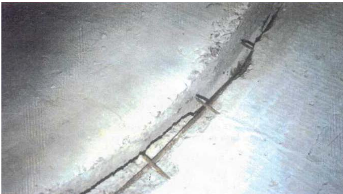
Рис. 88. Коррозия арматуры
