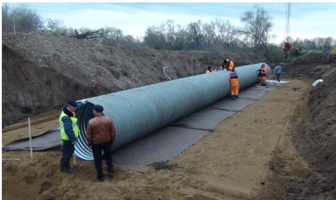
Рис. 76. Металлическая гофрированная труба, уложенная в ложе, вырезанное в песчаном нулевом слое
