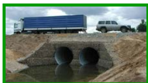
Рис. 76. Металлическая гофрированная труба, уложенная в ложе, вырезанное в песчаном нулевом слое
