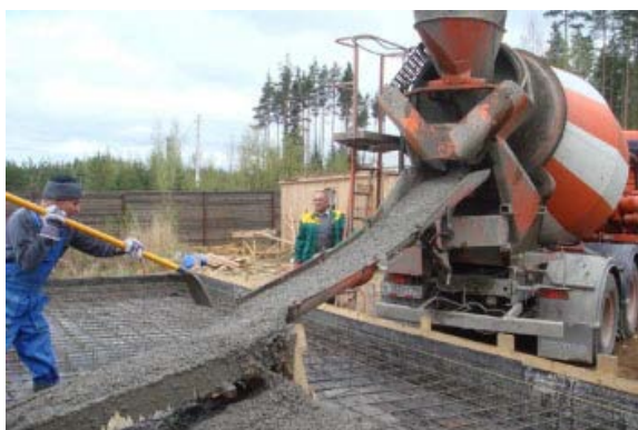
Рис. 57. Применение лотков для загрузки бетона в опалубку
