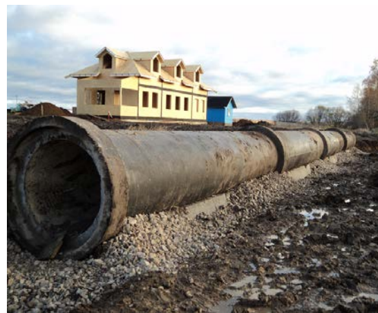
Рис. 70. Засыпка пазух между звеном и щебеночной подушкой
