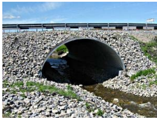
Рис. 17. МГТ с разомкнутым контуром арочного типа
