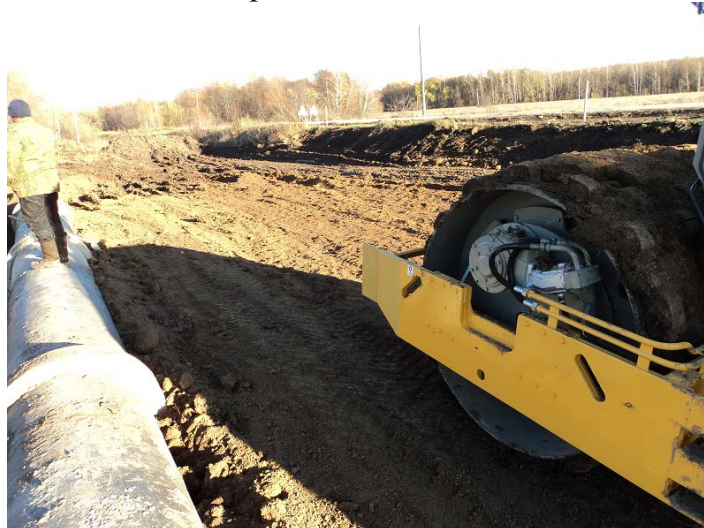
Рис. 110. Уплотнение грунта в грунтовой призме продольными проходами кулачкового катка
