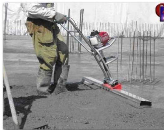
Рис. 63. Уплотнение бетонной смеси виброрейкой
