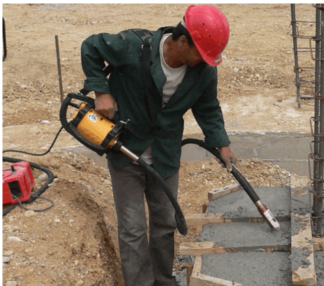
Рис. 61. Уплотнение бетонной смеси глубинным вибратором
