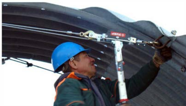
Рис. 85. Удерживание стандартного элемента в проектном положении крюком
