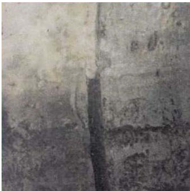
Рис. 86. Разрушение пескоцементного раствора в шве между звеньями круглой трубы с ее внутренней стороны
