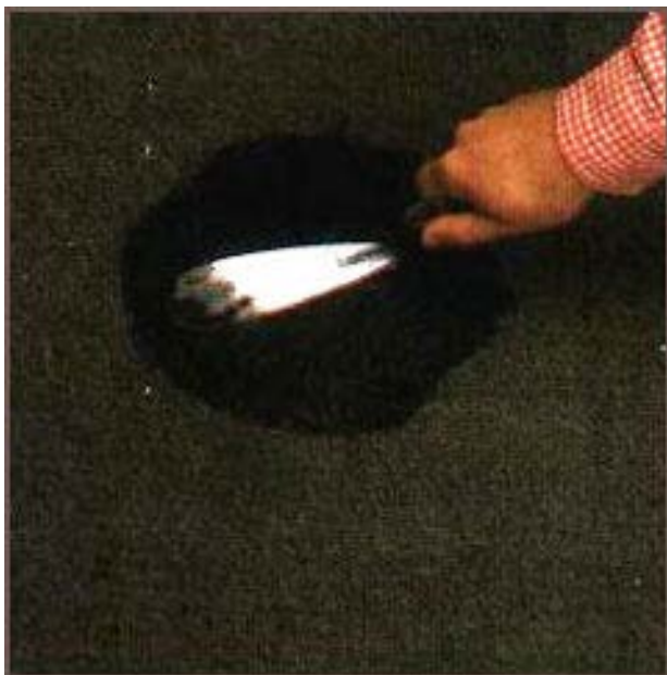
Рис. 101. Нанесение отделочного слоя битумной мастики поверх дефектного места
