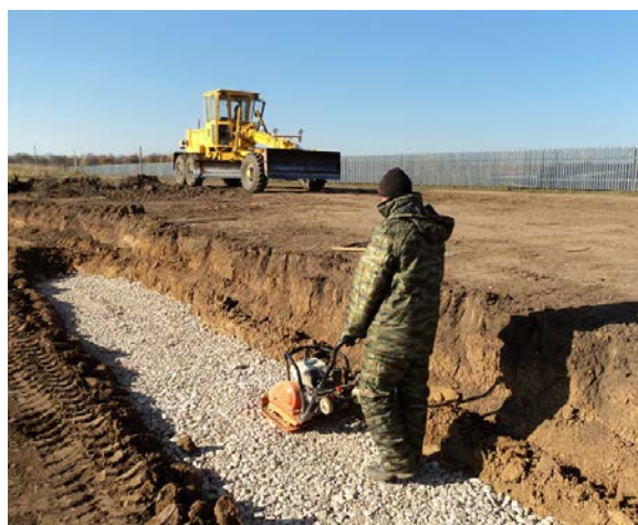
Рис. 54. Уплотнение материала подушки вибрационной плитой
