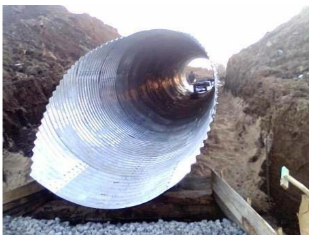
Рис. 12. Труба со скошенным торцом концевого звена
