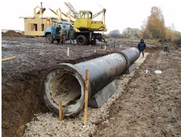
Рис. 69. Звенья трубы, установленные на лекальные блоки
