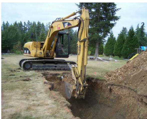
Рис. 45. Разработка грунта экскаватором, оборудованным обратной лопатой (боковой забой)
