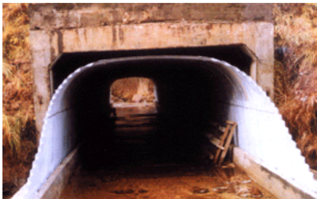
Рис. 16. МГТ с разомкнутым контуром коробчатого типа
