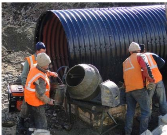
Рис. 108. Нанесение мастики способом подливки
